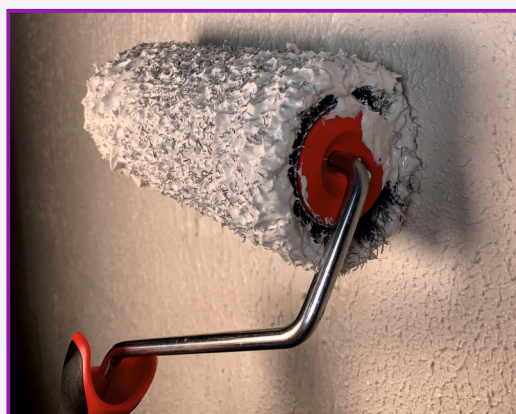
Nanášení stěrky válečkem na podklad
