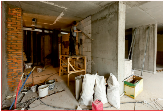
V průběhu rekonstrukce
