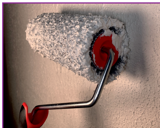
Nanášení stěrky válečkem na podklad
