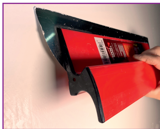
Finální vyrovnání nerezovou špachtlí pro dokonale hladký povrch
